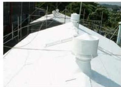
これまでの断熱材は、『熱伝導率&厚さ』によって計算・評価されてきましたが、このセラミック・カバーCC100は、屋根・外壁等使用時の熱反射を単独に生かす遮熱塗料に対し、『熱反射&熱伝導+境膜×各層』による複合的な働きにより断熱効果が得られる他に類を見ない特殊断熱コーティング材です。
