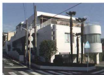
屋上・外壁の遮熱
