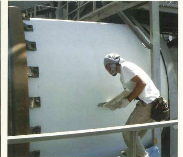
ドライヤーの外壁に
